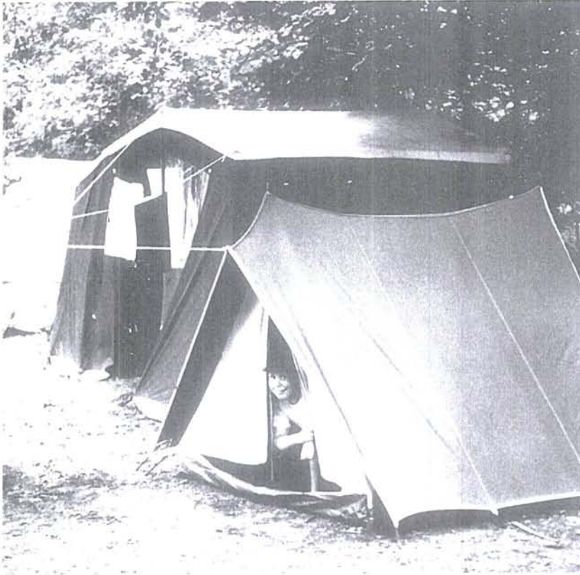
Neben den Hauszelten tauchen in den 1960er Jahren die Steilwandzelte auf; Sonnenwendfeier 1973 auf Hammerstein, im Zelteingang Sammy Kieserg.
