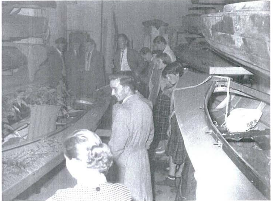
Lagerung von Booten auf Holzregalen entlang den Wänden in der kleinen Halle des alten Bootshauses (1957).
