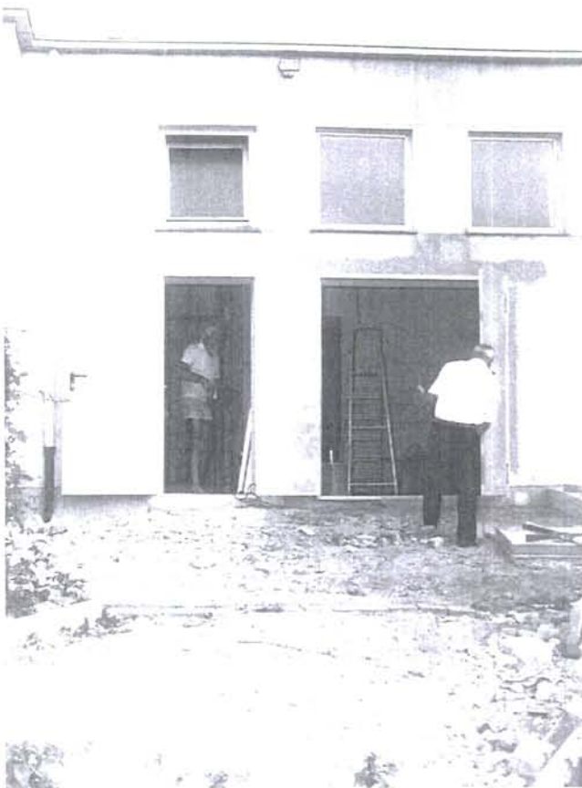
Es mußten Mauern durchbrochen und neue Türen eingesetzt werden; rechts die Tür zur kleinen Bootshalle; Dietmar Disl und Leo Spindler.
