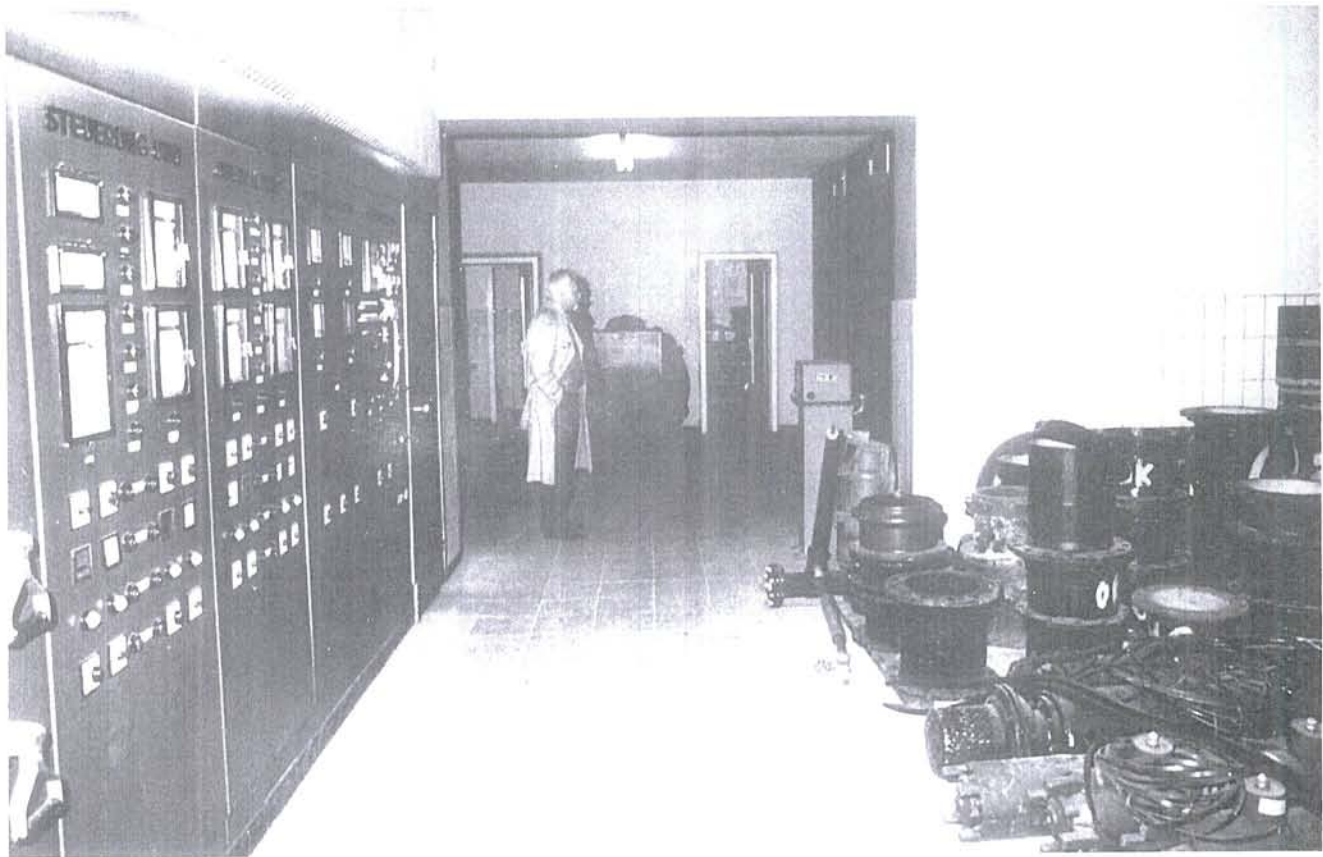
Dietmar Disl beim Betrachten der anstehenden Probleme. Denn bevor mit dem Innenausbau begonnen werden konnte,...
