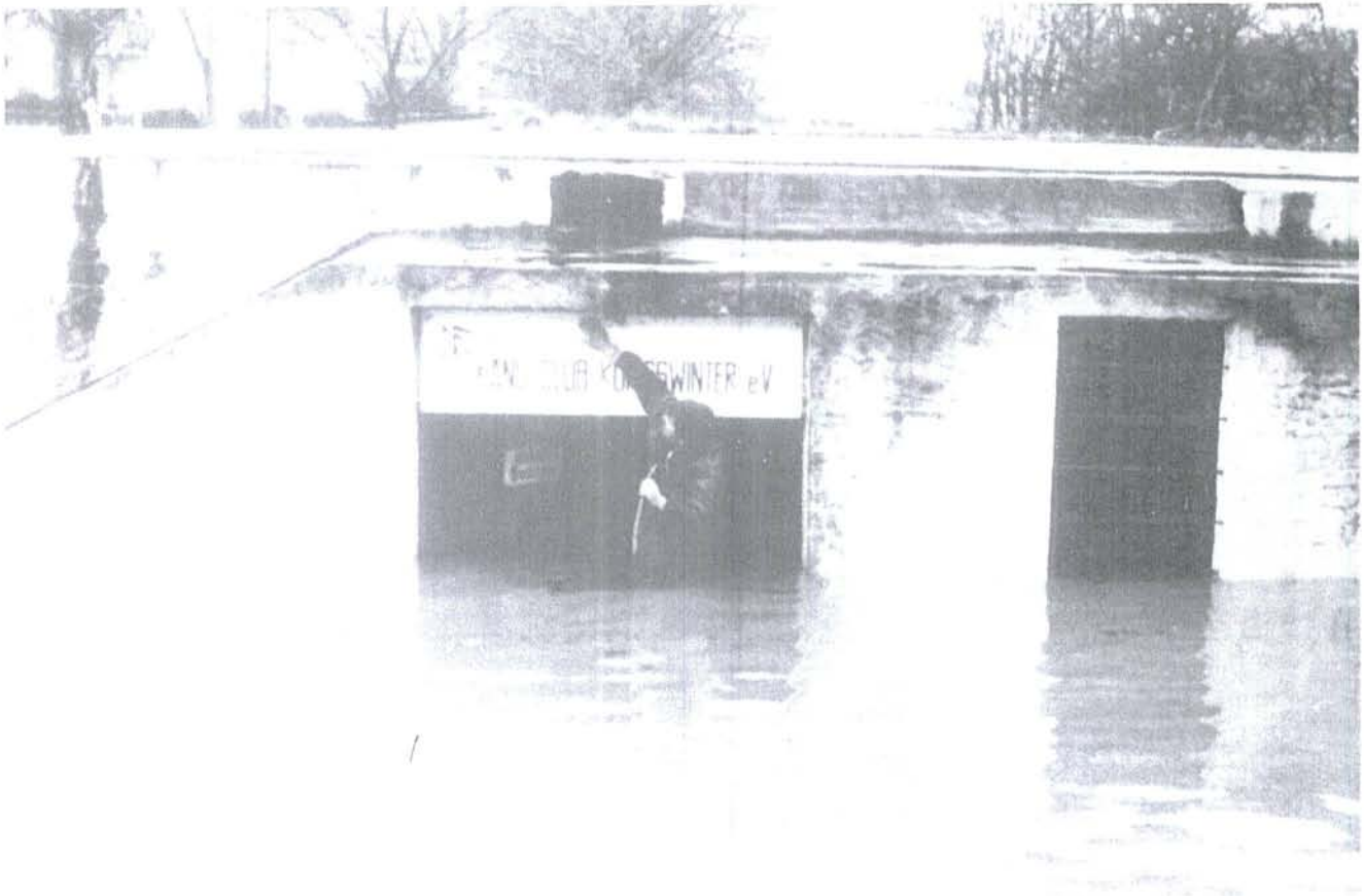
Im Gegensatz zum jetzigen Bootshaus am Wasserwerk war das alte Bootshaus an der Knabenstraße nicht hochwassersicher und mußte spätestens bei Wasserspiegellagen von 8,00 m Pegel Köln geräumt werden (April 1983).
